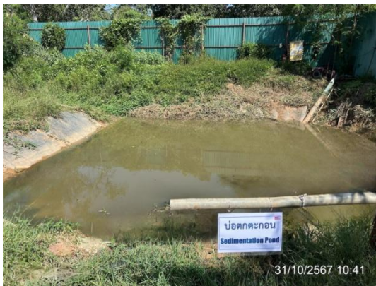
รูปที่ 3-28 บ่อดักตะกอนน้ำชั่วคราว ภายในพื้นที่โครงการ
