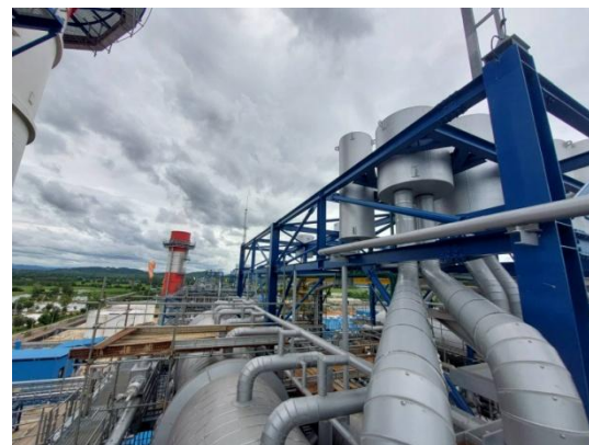
รูปที่ 3-48 อุปกรณ์ลดเสียง (Silencer) ขณะทดสอบเครื่องจักร (Commissioning)
