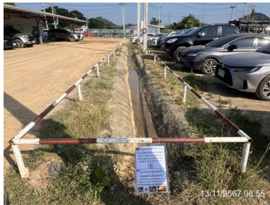
รูปที่ 3-27 รางระบายน้ำภายในพื้นที่โครงการ
