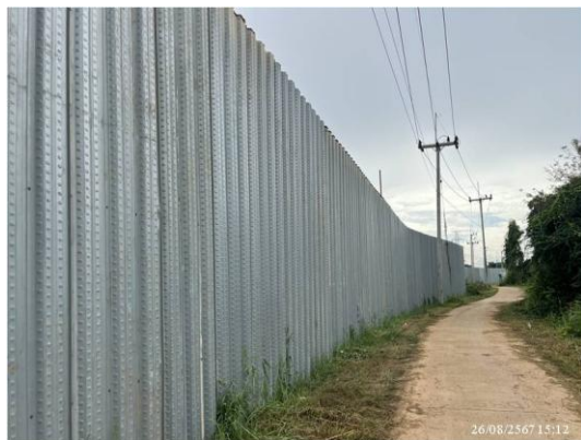
รูปที่ 3-13 กำแพงกันเสียงชั่วคราวบริเวณบ้านหลังโรงไฟฟ้า (ด้านทิศใต้ของโครงการ)
